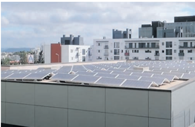
► Figura 4.9. Exemplos de instalações fotovoltaicas no meio edificado: cobertura curva numa estação de comboios (esquerda, superior); painéis orientados Este-Oeste num supermercado (esquerda, inferior); módulos semi-transparentes em fachada (direita, superior); e estrutura de sombreamento num estacionamento (direita, inferior). (Fontes: FirstRule, Solis-Lisboa, GJP, SunEnergy).
